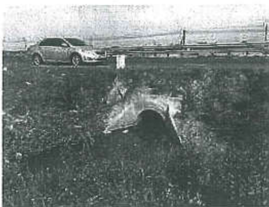
Hình 1.5: Cống tiêu hiện trạng từ phía đường sắt qua QL10
