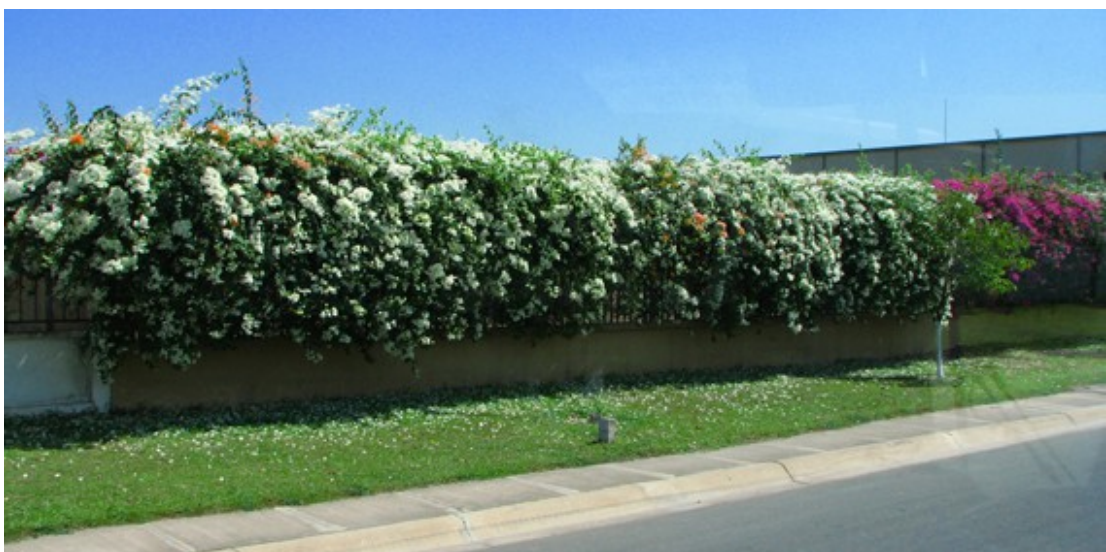
Trục đường chính KCN với hệ thống cây xanh và lối đi bộ trên hè đường
